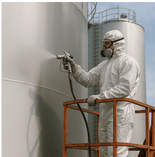
Рисунок 2.1 – Антикоровійний захист резервуару
