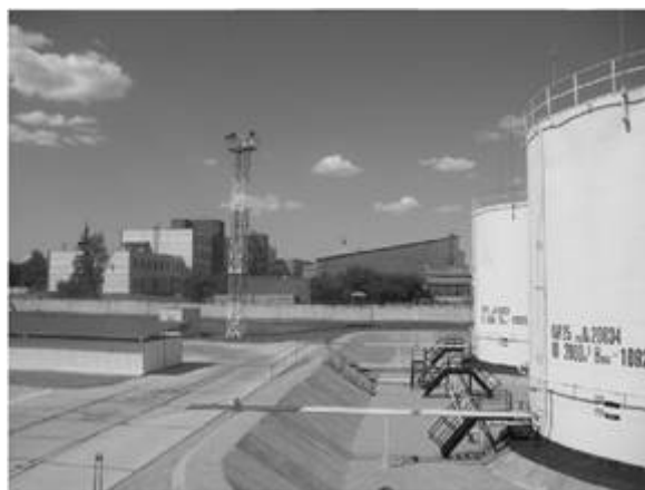
Риснок 2.2 – Обвалування резервуару
