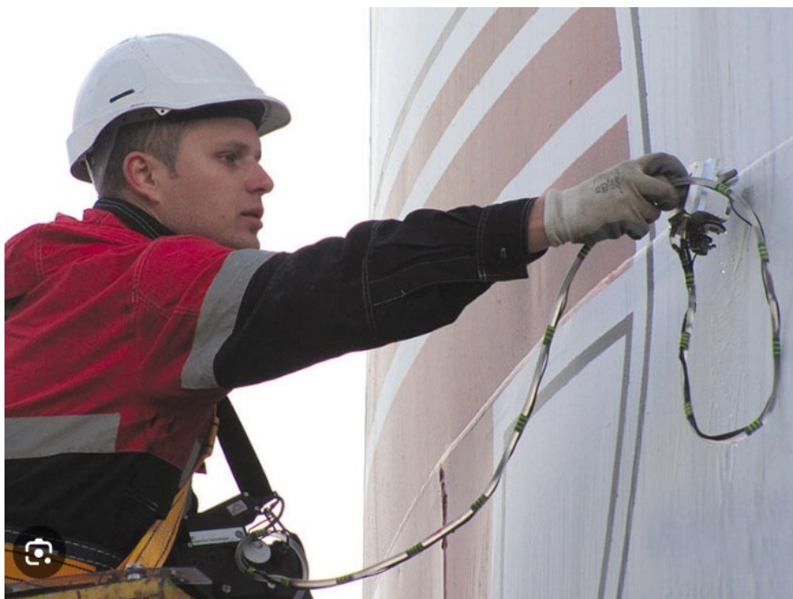
Рисунок 1.9 – Технічне обстеження резервуарного парку
