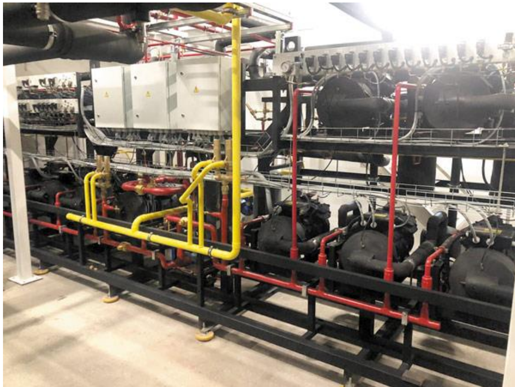
Рис. 1.28 Компресорний агрегат виробництва Elementum для проекту Metro, Солнцево.
