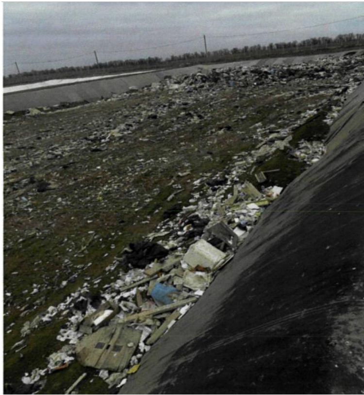
Рис. 2.3 – Загальний вигляд робочої карти після формування проміжного ізоляційного шару
