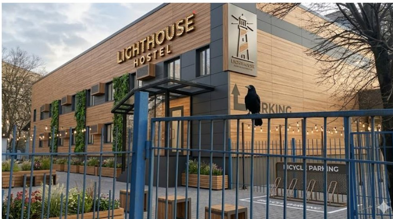
Рис.2.1. Фасад будівлі «Light House» до та після
