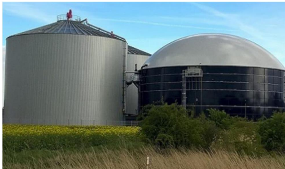
Рисунок 3. 6 – Газгольдер
