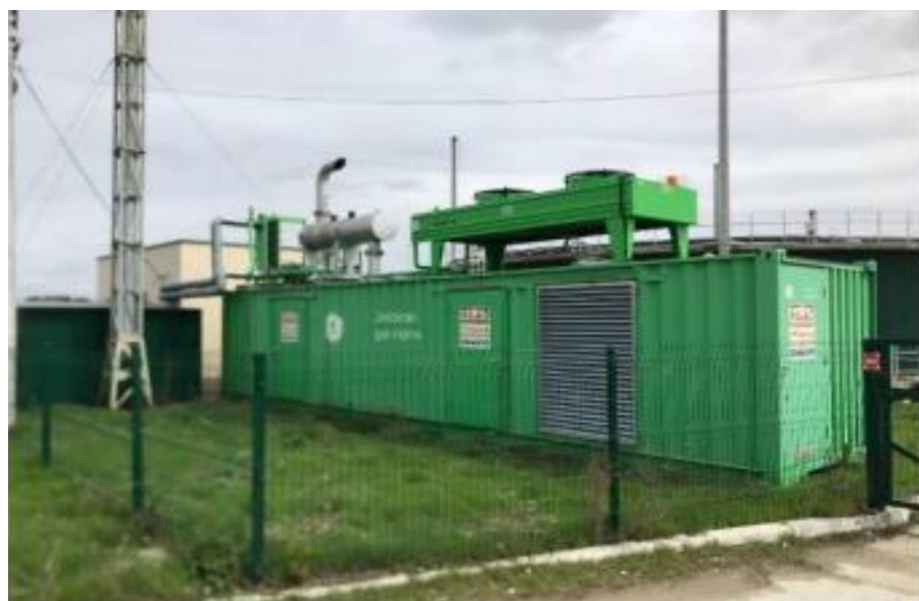
Рисунок 3.7 – Когенераційна установка
