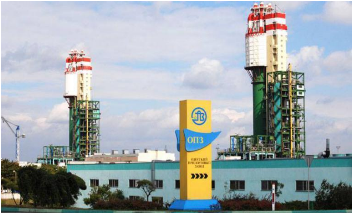
рис. 1.1 Зовнішній вигляд цеху синтезу аміаку.
