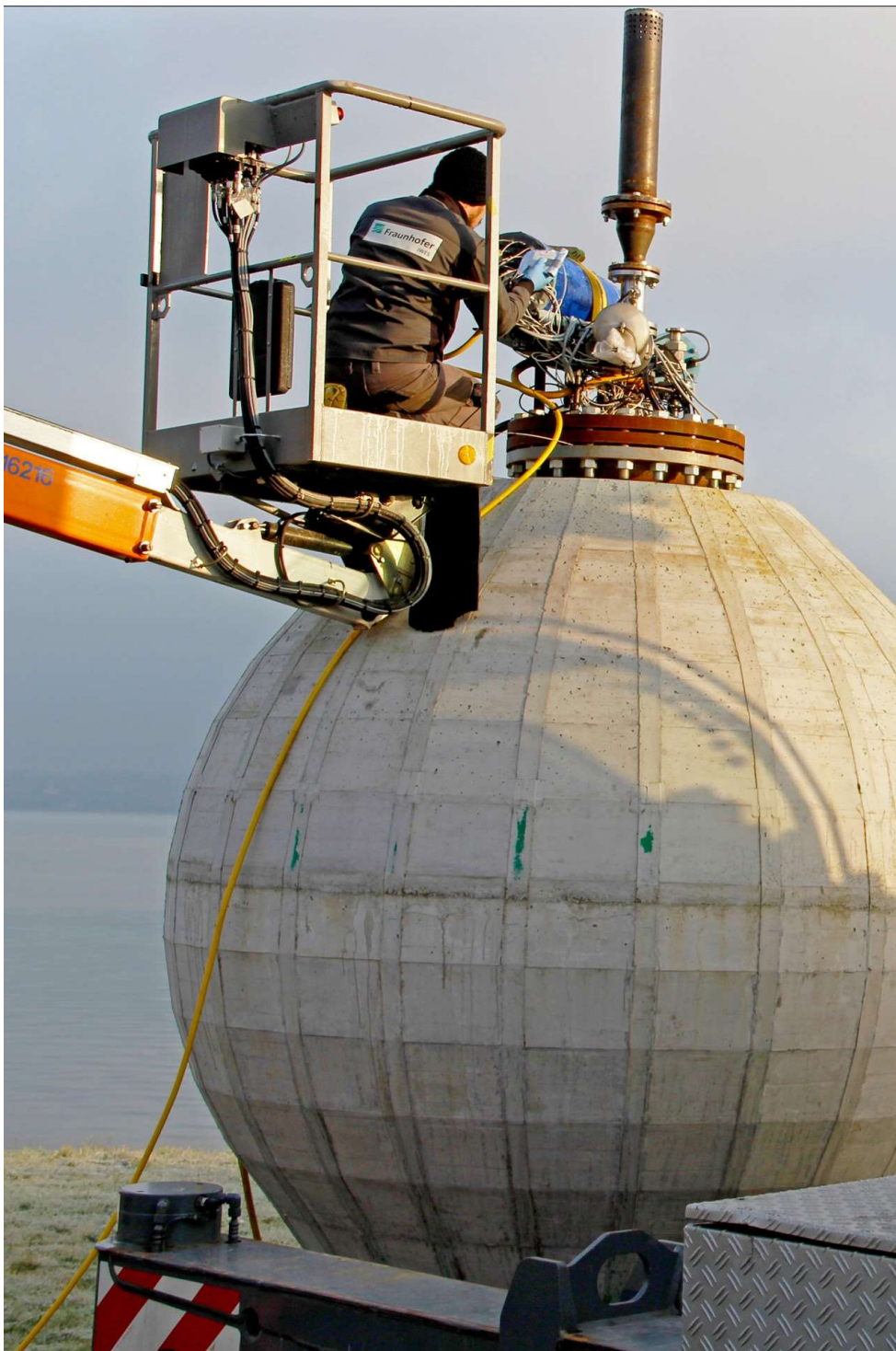
Рисунок 3.3.2-Підготовка до підводного монтажу бетонної кулі
