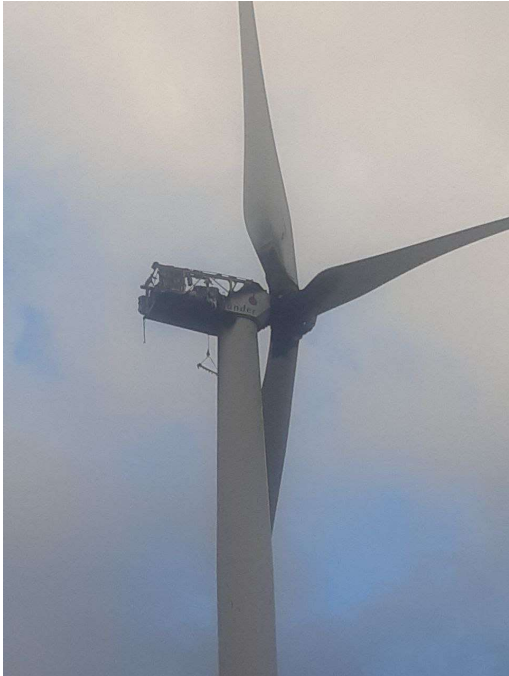
Рисунок 1.3.1 Пошкоджений вітрогенератор в результаті обстрілу з боку РФ у м. Очаків
