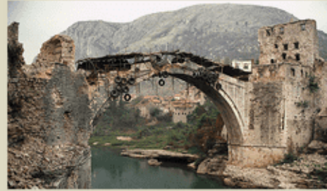
Зруйнований міст у Мостарі, листопад 1993
