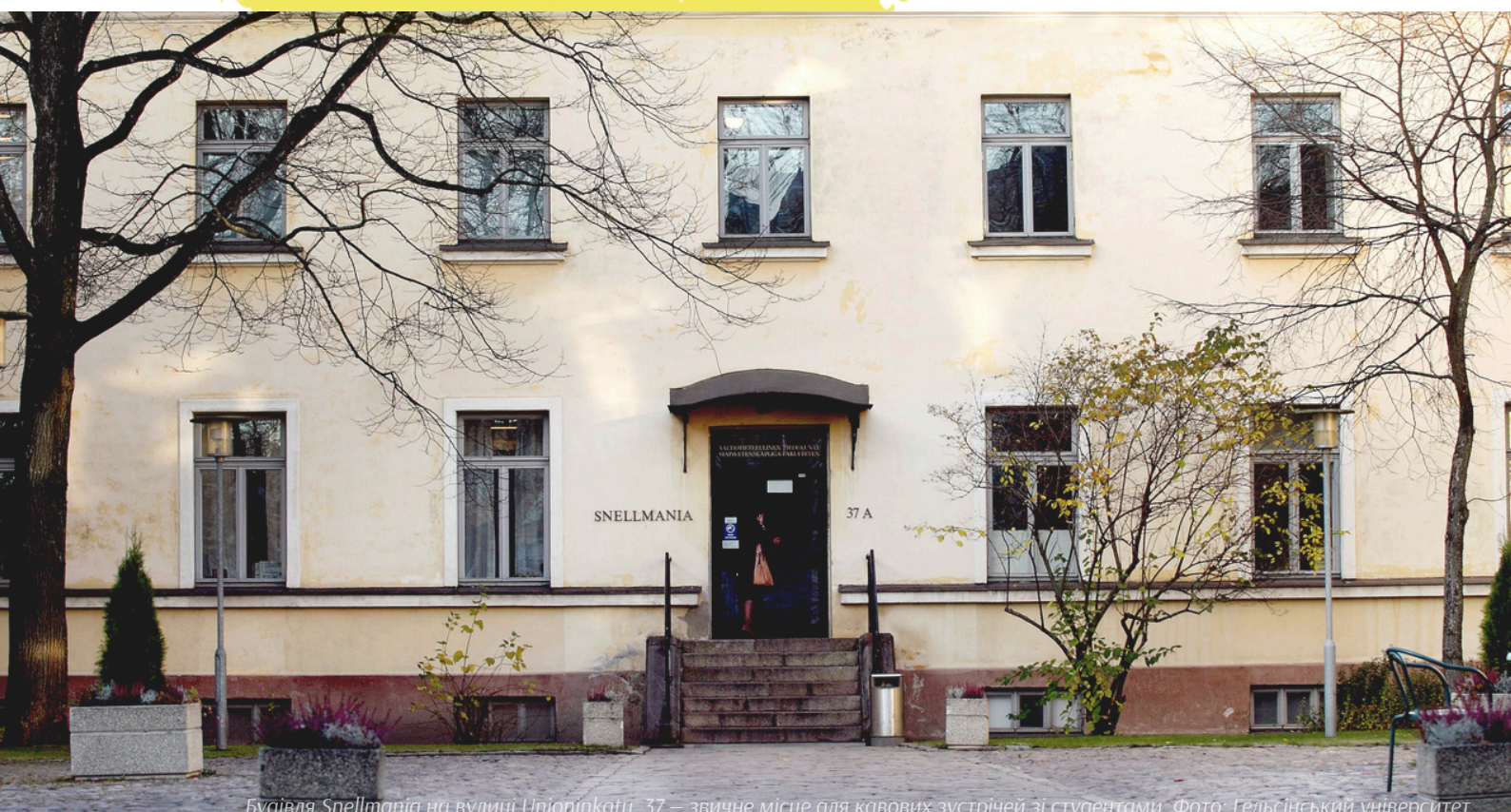
Будівля Snellmania на вулиці Unioninkatu, 37 – звичне місце для кавових зустрічей зі студентами. Фото: Гельсінський університет
