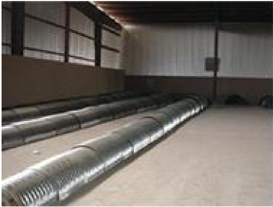
Рисунок 4.5. Камера з системою активного вентилявання при зберіганні овочів насипом
