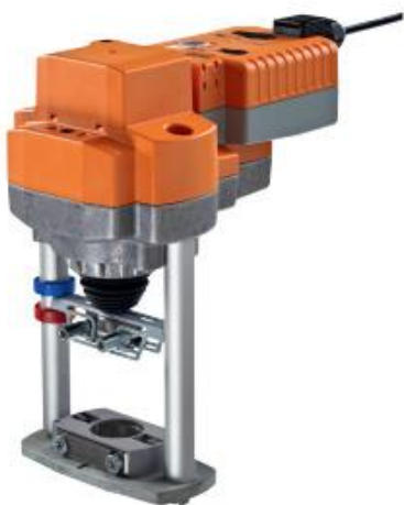
Рис. 5.5 Виконавчий механізм Belimo AVK24A
