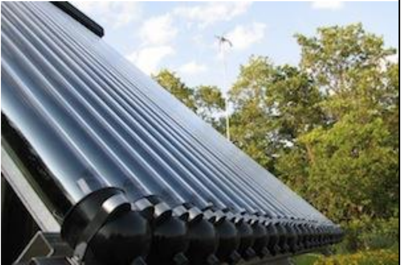
Рисунок 5.2 – Вакуумний колектор.
