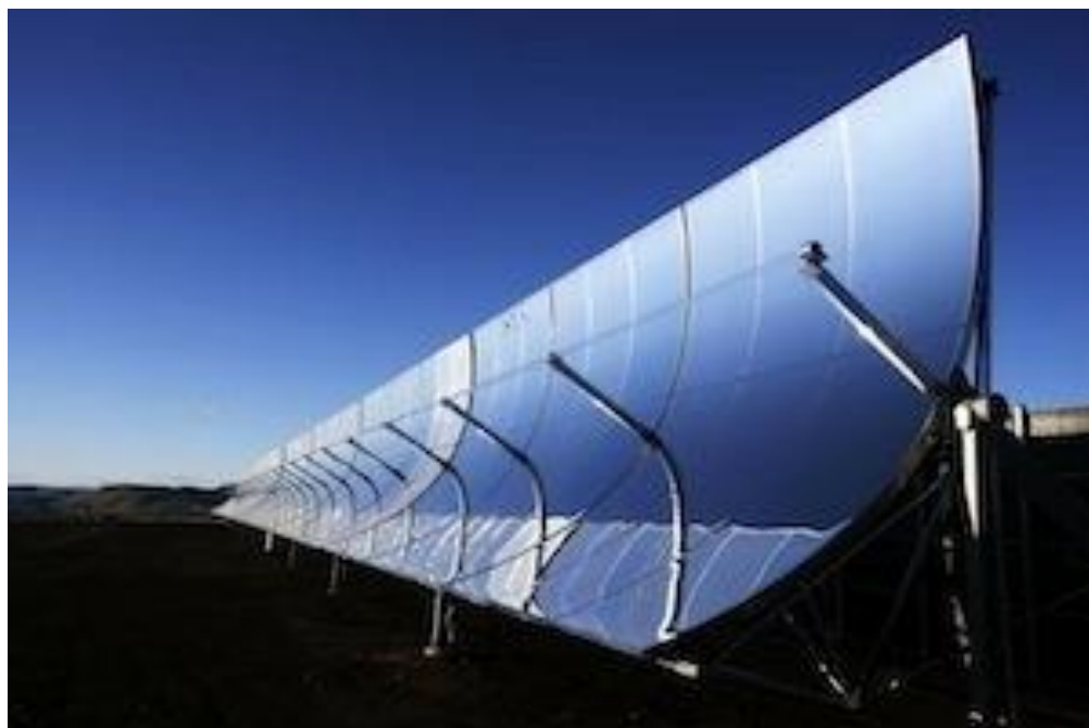
Рисунок 5.3 – Параболічний сонячний колектор
