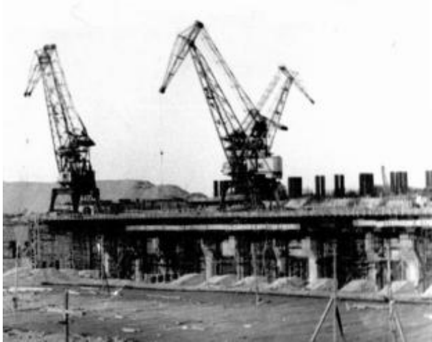
Рисунок 1.6 – Будівельні порталні крани на бетоновозній естакаді
