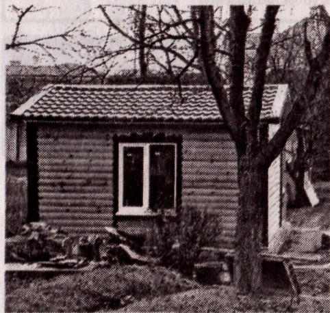
НАЧАЛО РЕКОНСТРУКЦИИ БАЗЫ «ДРУЖБА»
