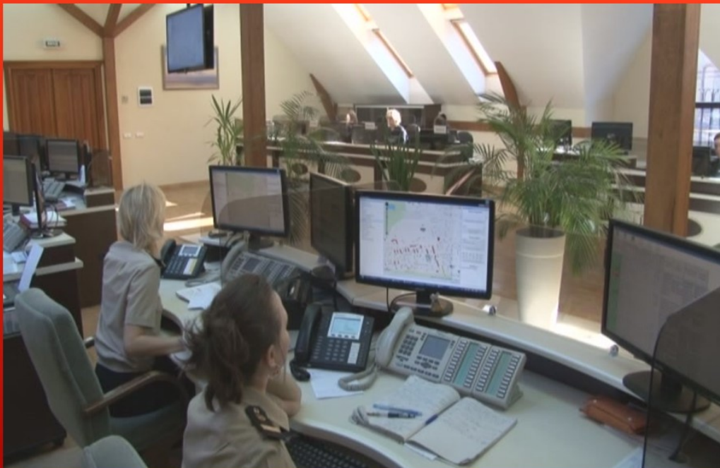
Обладнання диспетчерського пункту Системи 112
