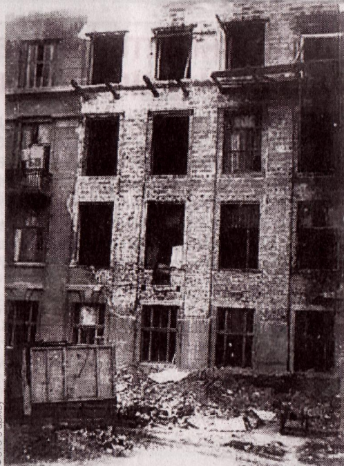
ЗРУЙНОВАНИЙ НАВЧАЛЬНИЙ КОРПУС
