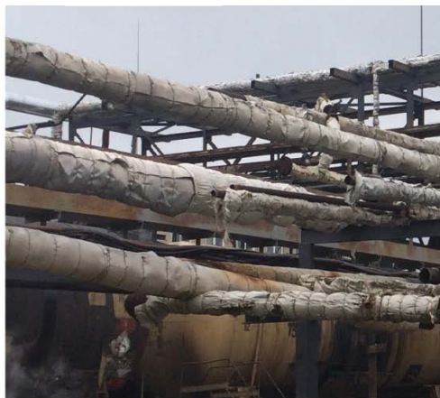
Рисунок 1 – Паропровод подогрева резервуарных блоков до реконструкции
