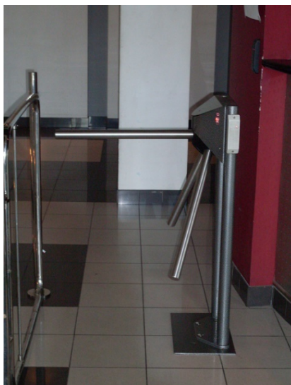
Рисунок 1.1. Турнікет зі зчитувачем системи контролю доступом
