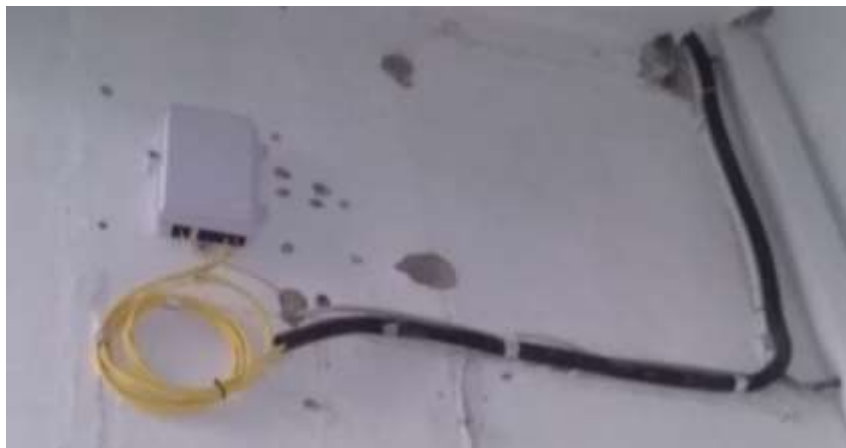
Рисунок 1.6. Бокс ONU/ONT на сходах другого поверху
