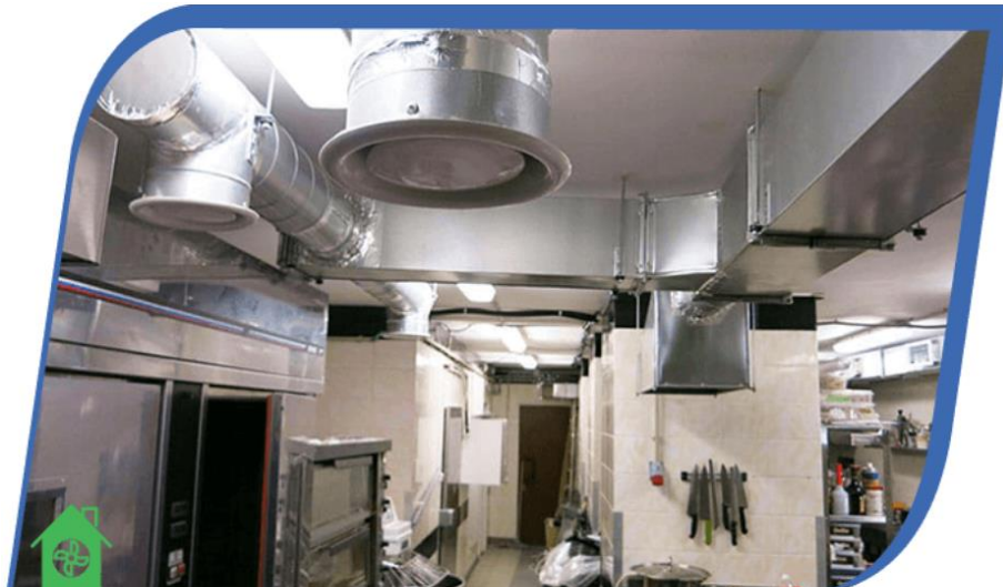
Мал.1 Системи вентиляції гарячого цеху ресторану
