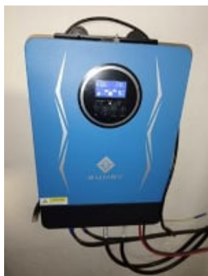
Рисунок 3. а - гібридний сонячний інвертор, б - акумуляторна батарея LPBF24100-M Felicity
