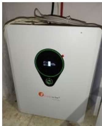
Рисунок 3. а - гібридний сонячний інвертор, б - акумуляторна батарея LPBF24100-M Felicity
