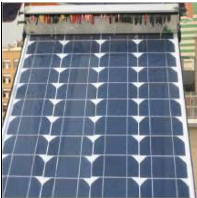
Рисунок 3.14. Сонячна фотоелектрична панель з плівкоутворюючим пристроєм
