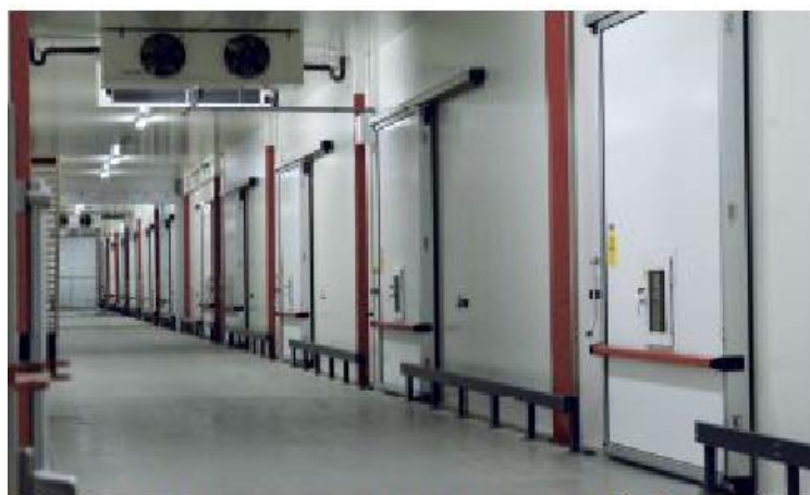
Рис.2 Камери з РГС для зберігання яблук
