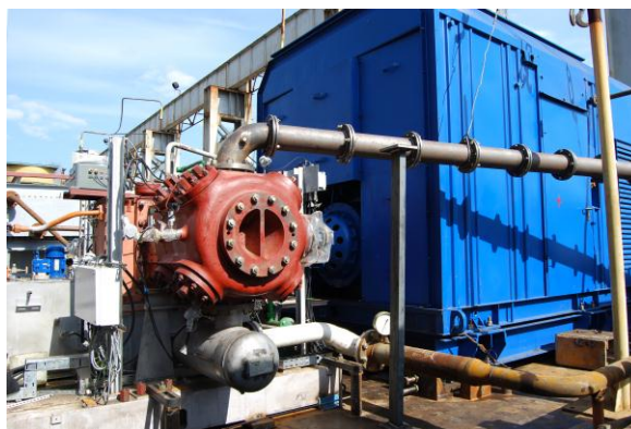
Рис 1. Испытания установки 2GM10A-II-18/9-26 в режиме резонансного наддува.
