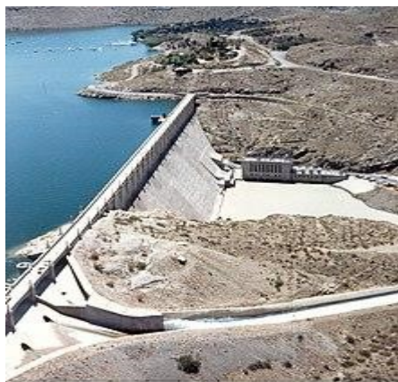
Рис.11. Гідроелектростанція в Нью-Мексико (США)
