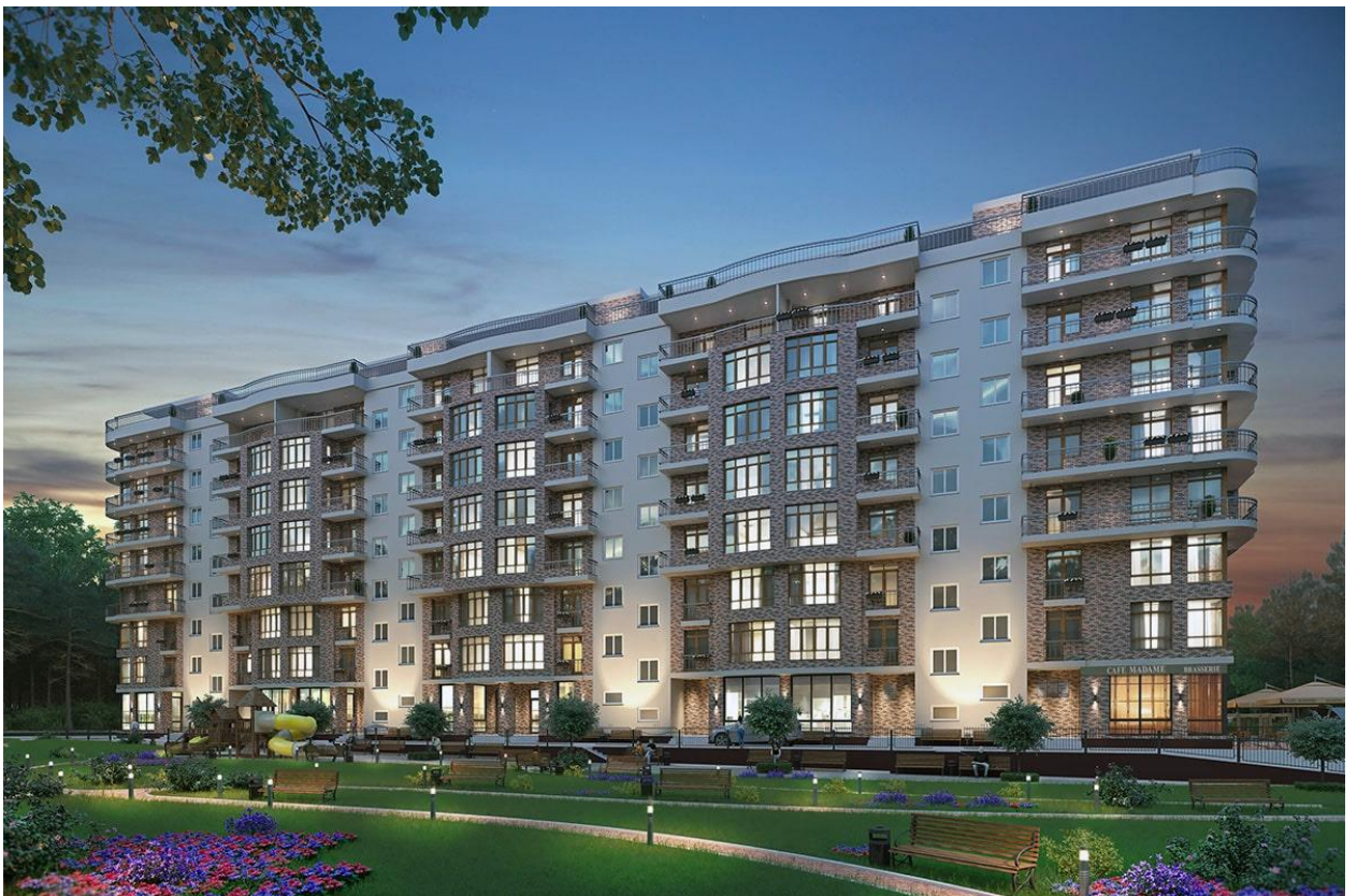
Мал.3.3 Зовнішній вигляд будівлі із пентхаусом
