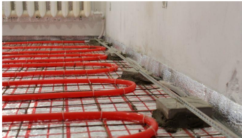
Рис. 5.3. Укладання петель теплої підлоги
