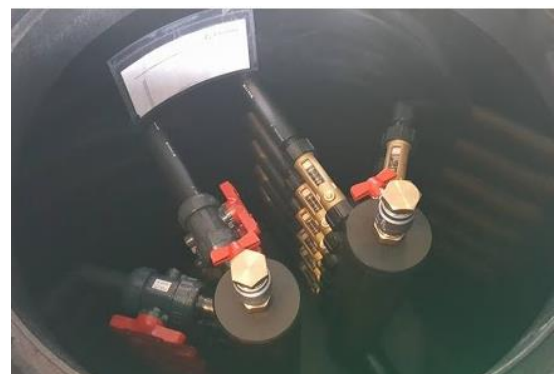
Рис. 12.4. Зовнішній вигляд ґрунтового колектора
