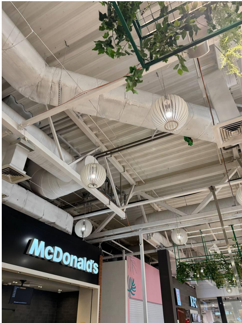
Рисунок 1.1 - Інтер'єр ТРЦ «Рів'єра» з відкритими стельовими повітроводами системи кондиціювання
