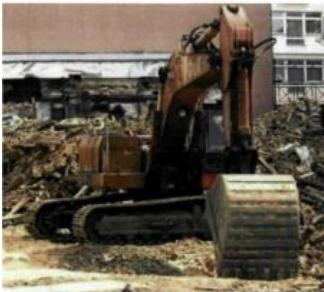
Рис. 1.1 – Процес підготовки майданчика для проведення будівельних робіт
