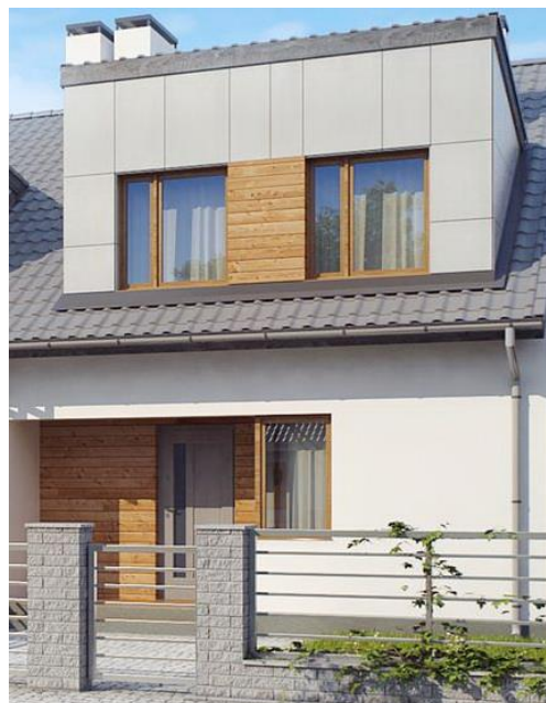
Рис.3.2 Північний фасад блоку таунхаусу
