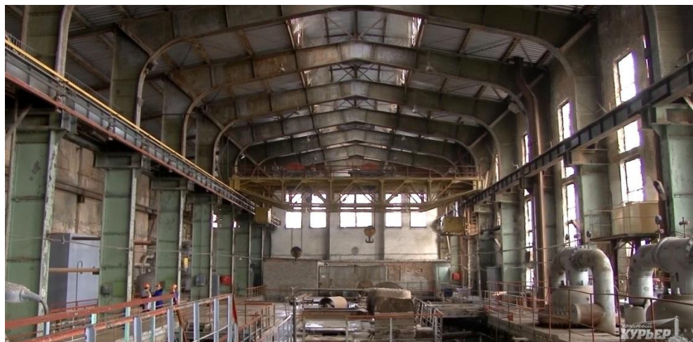
Рисунок 1.4. Вигляд приміщення ТЕЦ
