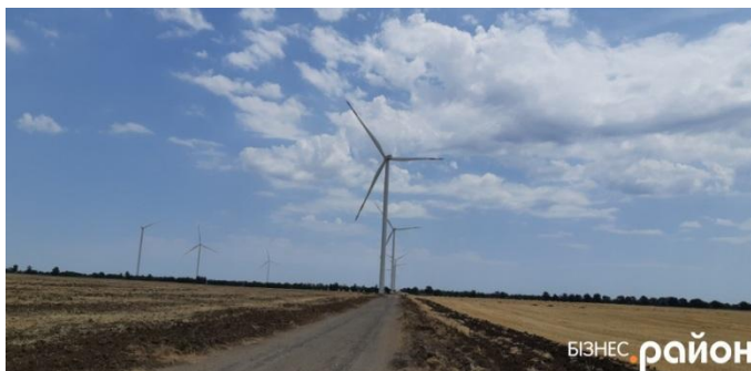
Рисунок 1.11. Вітрова електростанція Одещини [2]
