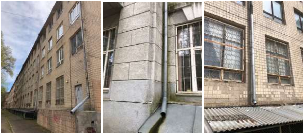
Рисунок 1.13 - Дощові водостоки на будівлях навчальних корпусів ОНТУ
