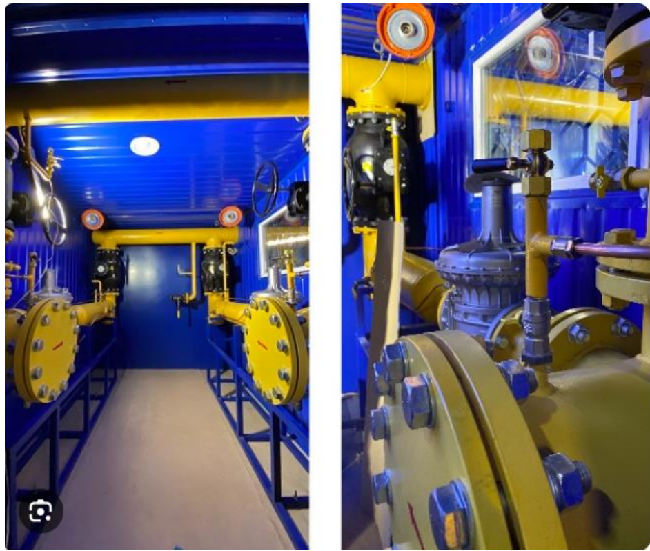
Рис. 2.1. Блок редукування тиску
