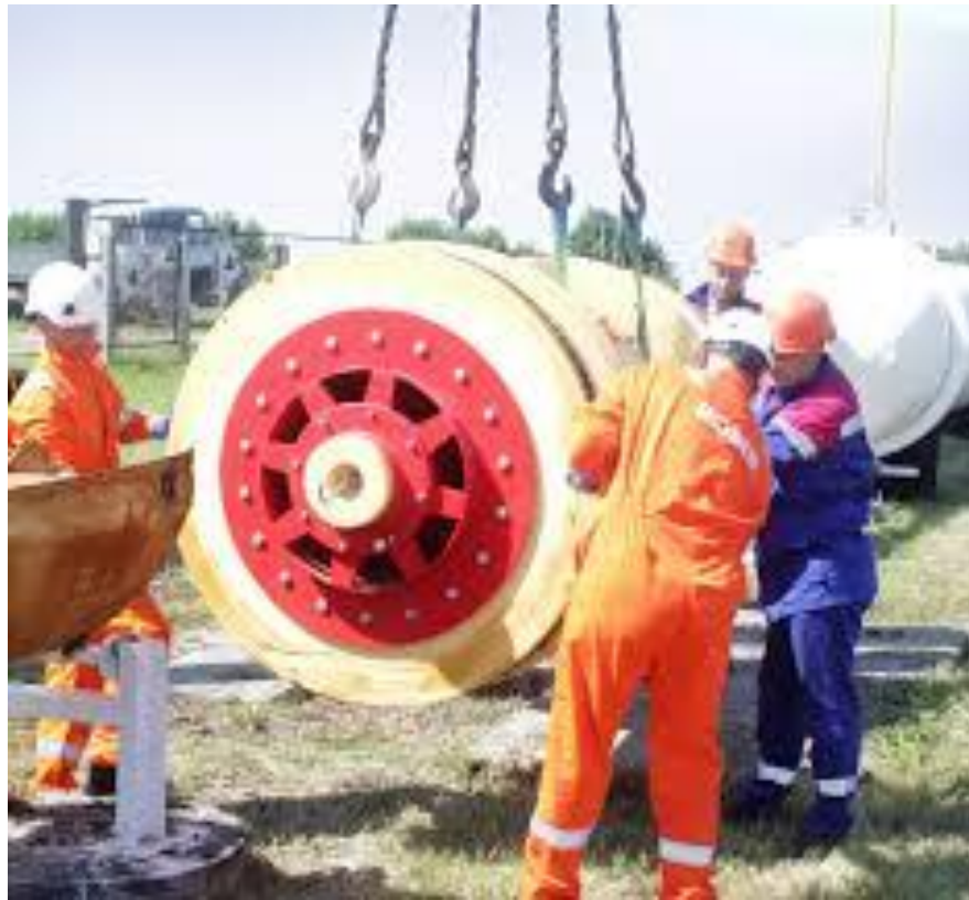
Рис. 2.4. Осушення порожнини газопроводу
