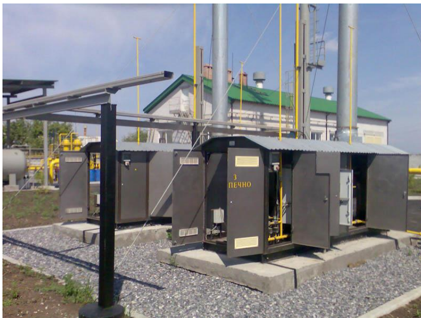
Рис. 2.2. Підігрівачі природного газу серії ТК-ПГ-М
