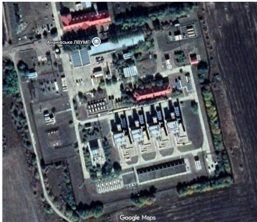
Рисунок 1.14 - Компресорна станція Ананьїв
