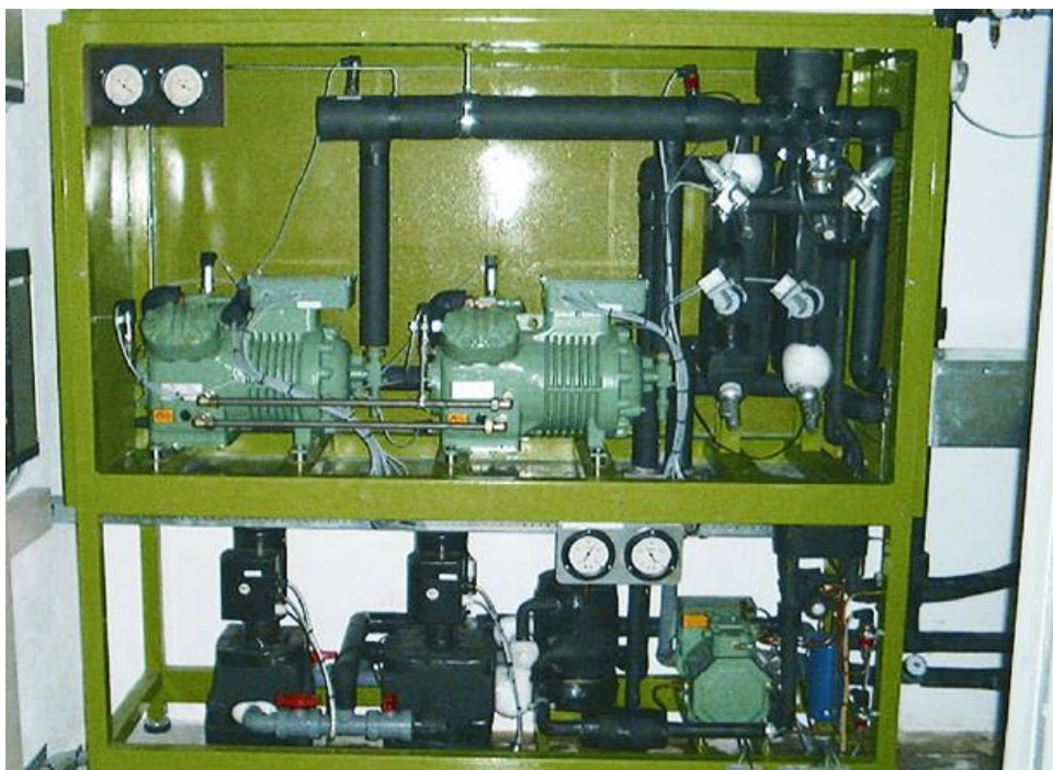
Рис.20. Каскадна холодильна машина CO 2 - аміак [10]
