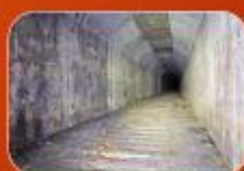
підземний дренажний тунель довжиною 5,2 км на річці Саксаган
