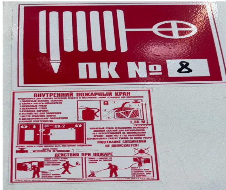
Рисунок 5.3 – Внутрішній пожежний кран-комплект пломбування внутрішнього пожежного крану представлено на рисунку 4.4
