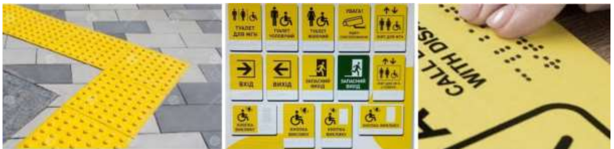
Рис. 20. Тактильні доріжки та знаки
