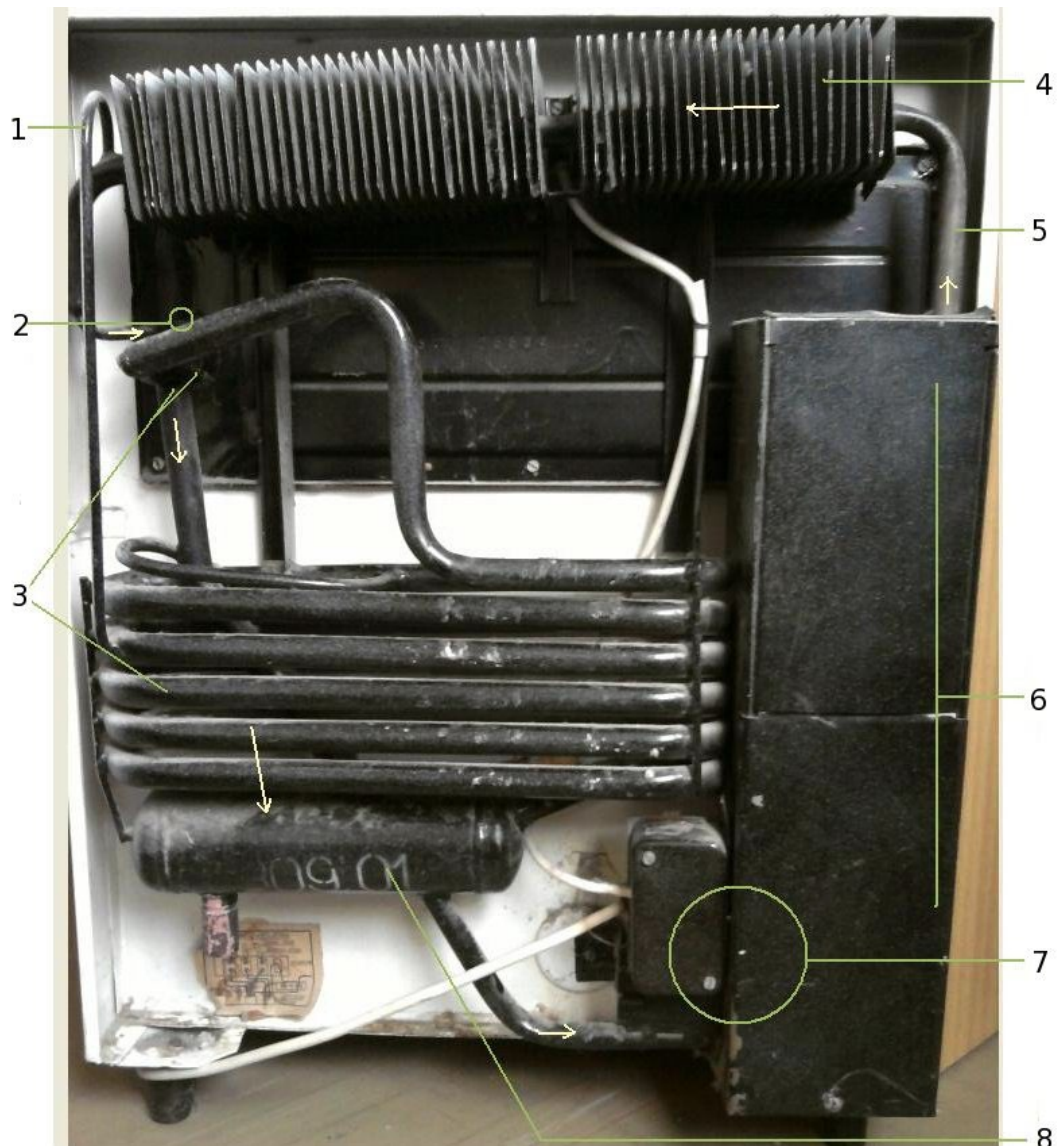
Рис. 1.4. Зовнішній вигляд агрегату абсорбційного побутового холодильника
