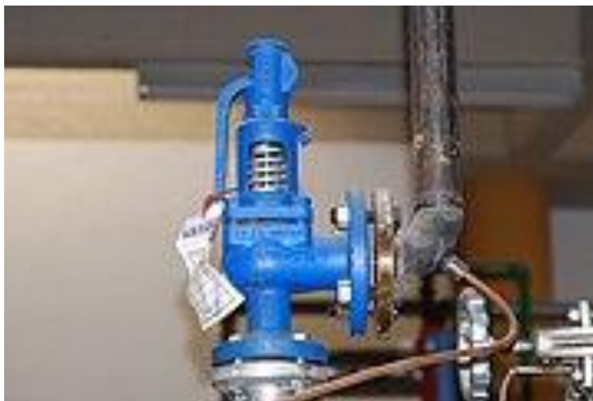
Рис 4.4 Пружинний клапан
