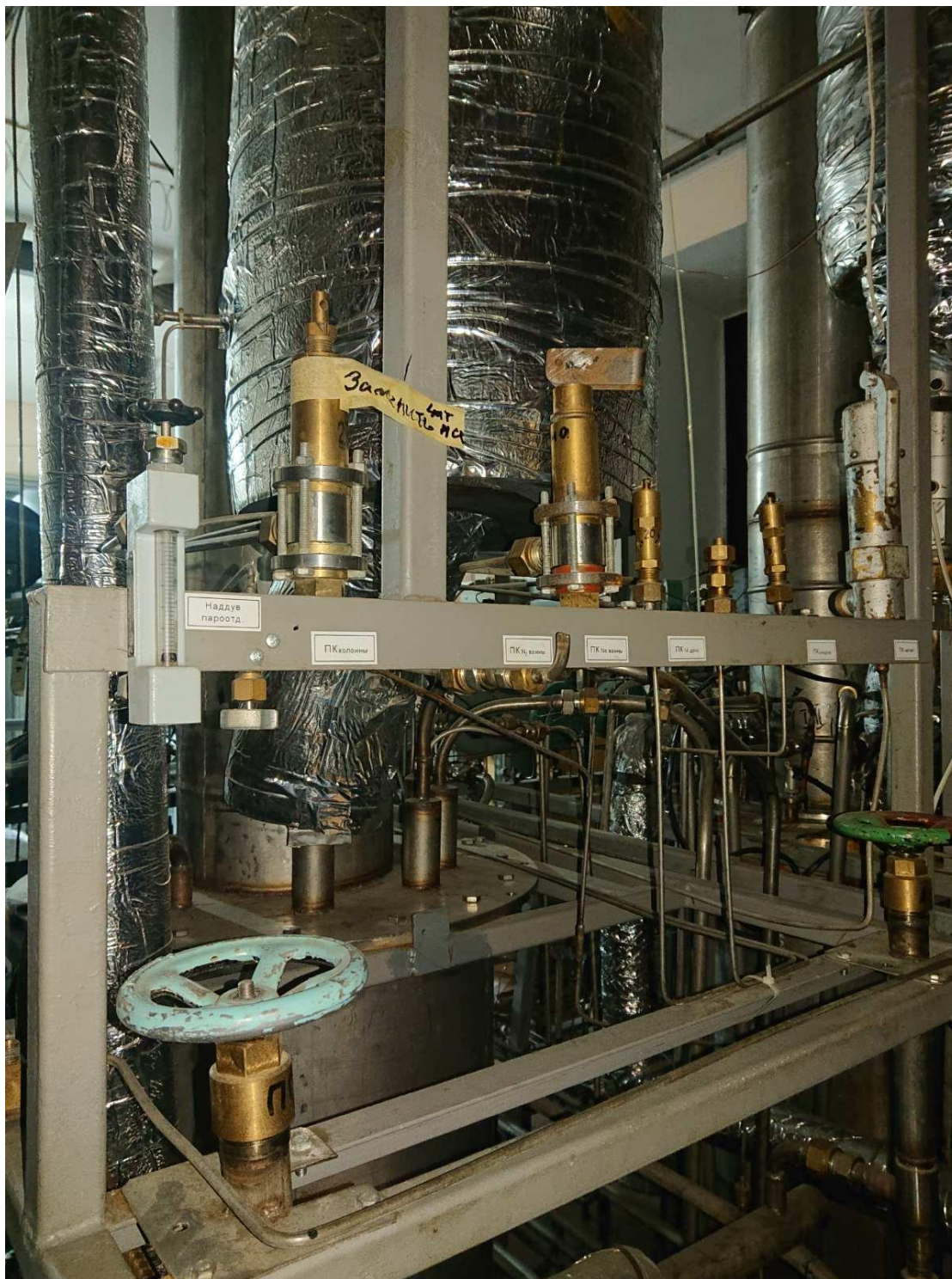
Рис 5.10 Застосування запобіжного клапану у лабораторії кріогенної техніки ОНТУ
