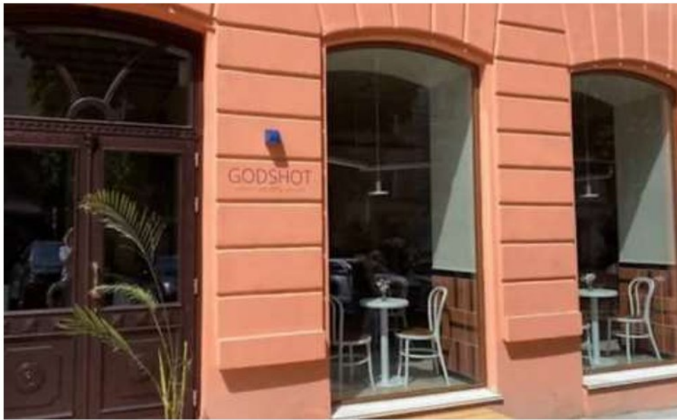
Рис.1.1 Приміщення для майбутнього закладу
