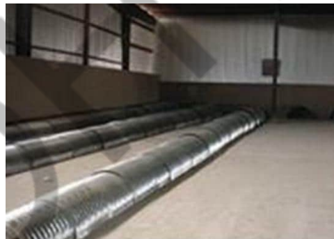
Рисунок 3 – Камери зберігання плодоовочевої продукції з системами активного вентиляювання: а) підлогова; б) з зовнішніми повітроводами
