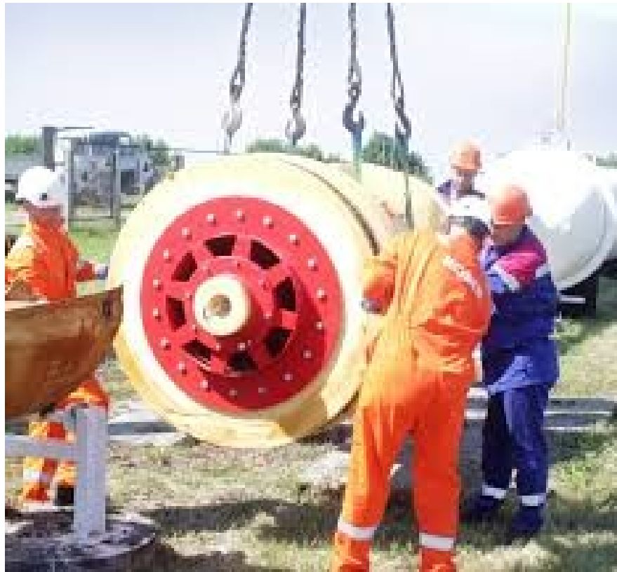
Рис. 2.4. Осушення порожнини газопроводу
