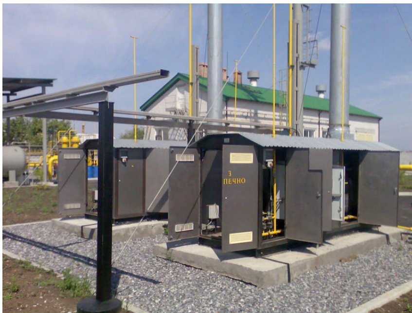
Рис. 2.2. Підігрівачі природного газу серії ТК-ПГ-М
