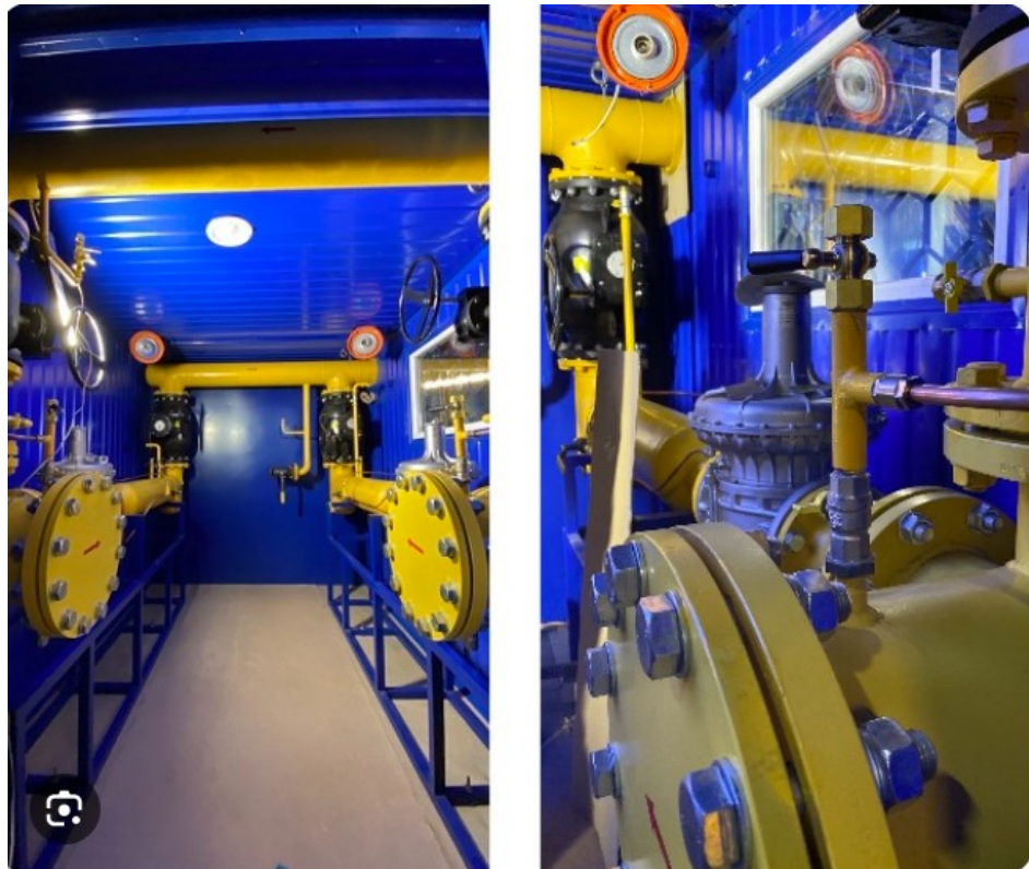
Рис. 2.1. Блок редукування тиску
