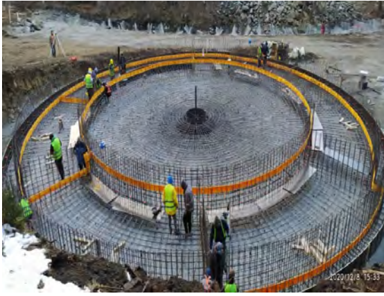
Рис. 3.18 – Будівництво аеротенку станції очищення стічних вод
