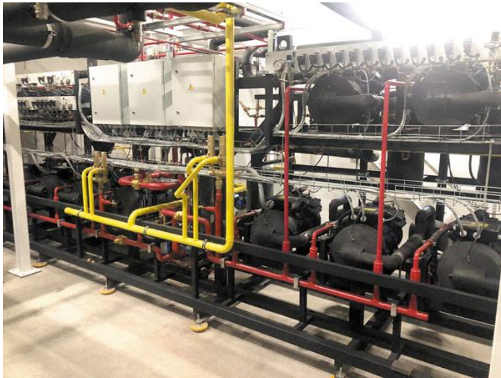
Рис. 1.28 Компресорний агрегат виробництва Elementum для проекту Метро, Солнцево.
