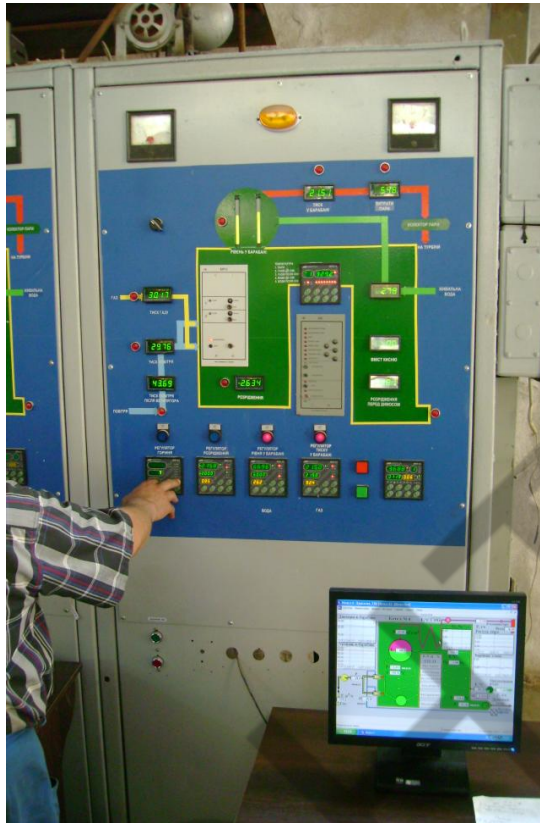
Рис. 1 – Узгодження мнемосхеми щита та екранної форми АРМ оператора
