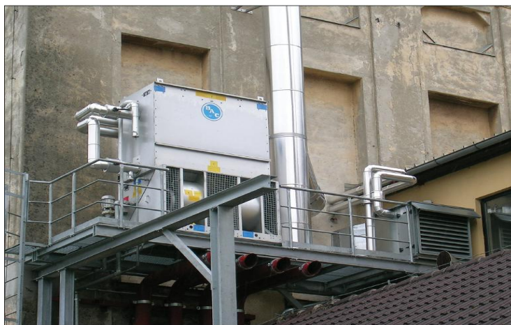
Рис. 1.4. Градирня системы оборотного охлаждения АБХМ и теплообменник охлаждения приточного воздуха газовой микротурбины
