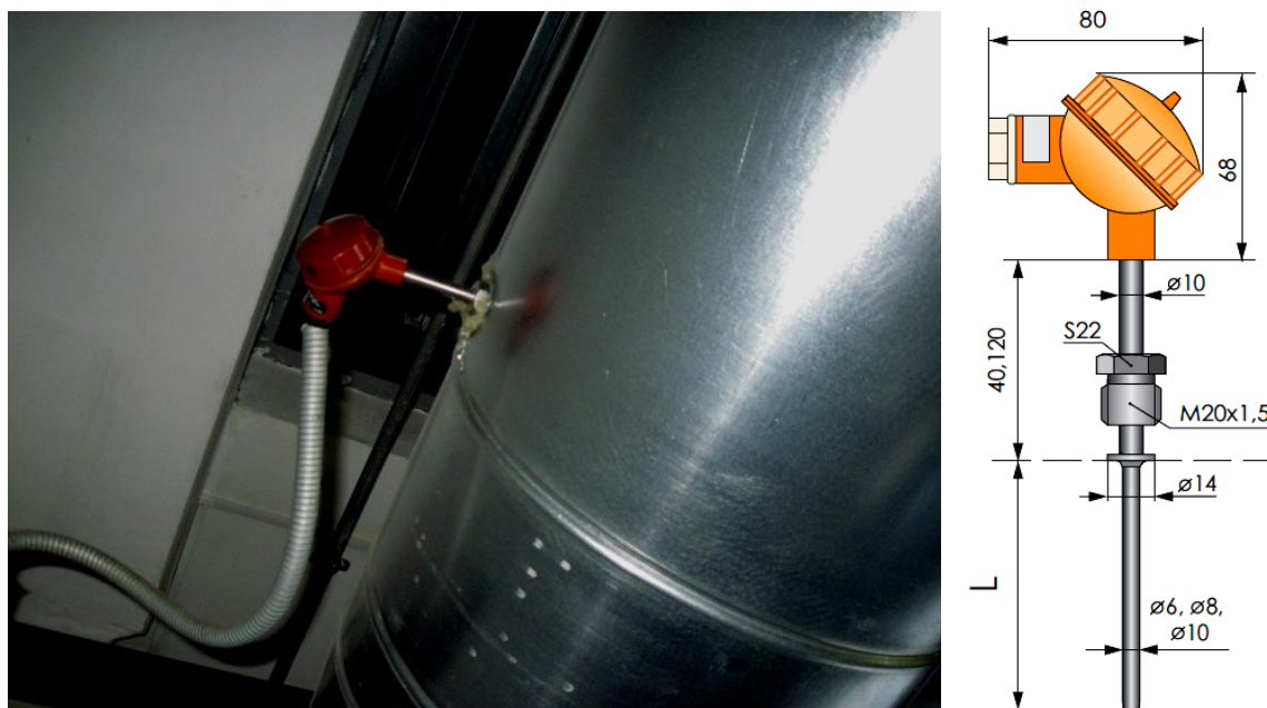
Рис. 3.3. Датчик температуры ТСПУ 1-3 Pt100 0,2 2 100 Ф6
