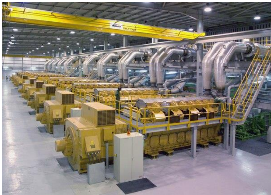
Рис. 1.4. Машинные отделения когенерационных электростанций на базе газовых двигателей с приточно-вытяжной системой вентиляции [11,61],
