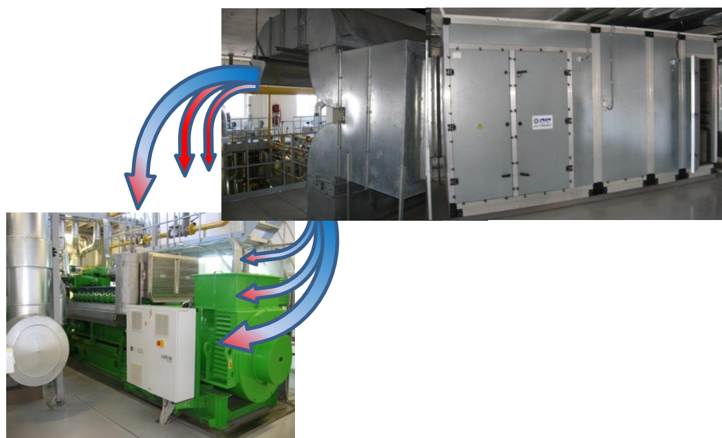
Рис. 2.1. Общий вид системы охлаждения приточного воздуха МО теплоиспользующим кондиционером SIC Jan HREBEC H63 (ООО "Сандора"—"Pepsico Ukraine")
