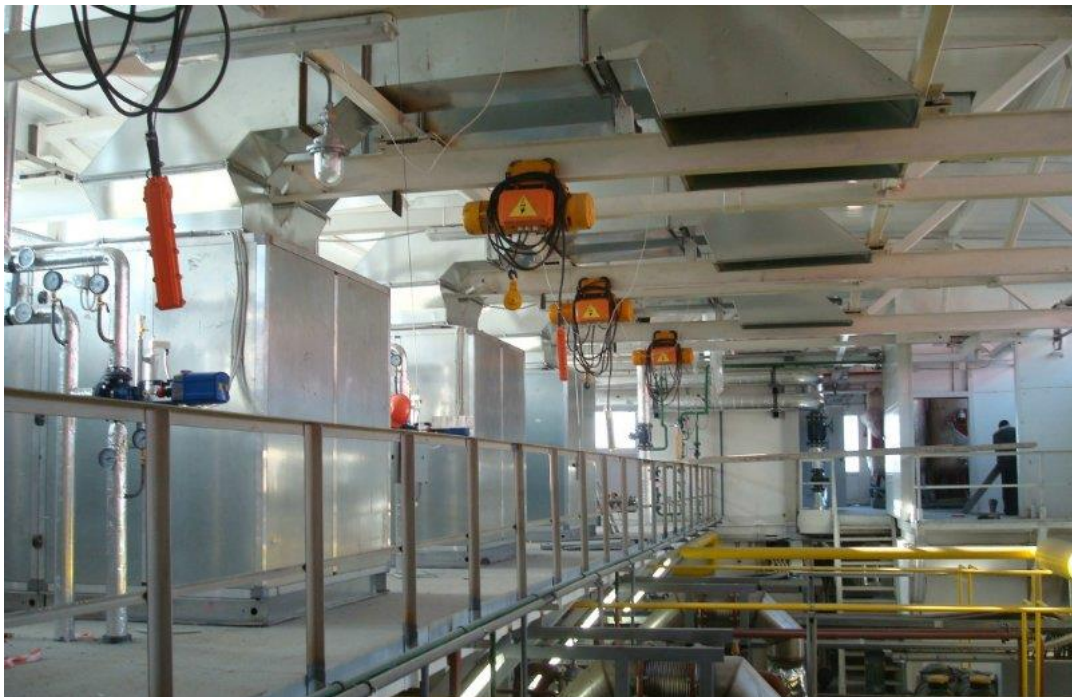
Рис. 1.10. Машинное отделение: a – тригенерационной установки с теплоиспользующим центральным кондиционером; б – энергокомплекса 2,4 МВт для сети гипермаркетов "Магнит", Россия, г. Лермонтов [127]
