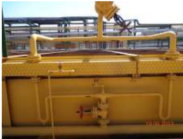
Рис. 1.6. Внешний вид теплообменника, состоящего из двух теплообменных пучков
